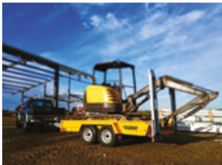
7h00 Livraison d'une mini-pelle pour un chantier de construction de bâtiment industriel
