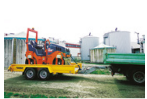
9h00 Arrivée dans une usine de méthanisation pour un chantier de compactage
